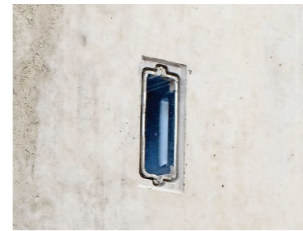
Der ASK Konsolenanker ist ideal für Sichtbeton. Keine Nägel und kompakte Masse.
