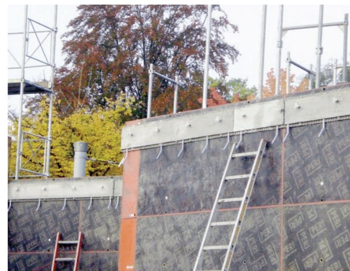
«BEGO» Deckenrandabschalung mit integrierten UNI-Betonhülsen zur Erstellung eines Auflagers für die obere Wandschalung.
