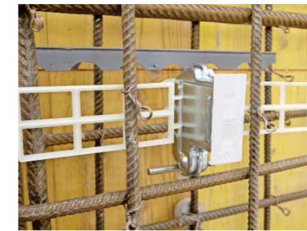
Um den ASK Konsolenanker an der inneren Schalung zu befestigen kann man ihn vorgängig an der Bewehrung anbringen.
