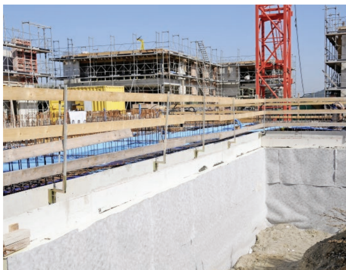
«BEGO» Deckenrandabschalung mit stossicherem Schutzgeländer. Nach dem Ausschalen ist die Deckenrandabschalung fertig erstellt.
