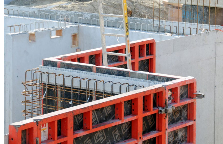
«BEGO»-Deckenrandabschalung: Nach dem Ausschalen ist die Decken-Stirnschalung automatisch fertiggestellt.
