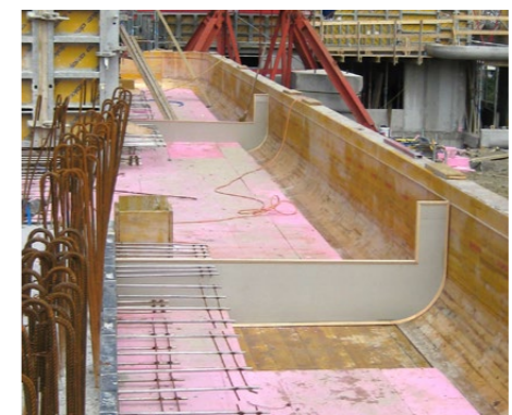
Mit den «DILA-Profi-Leisten» können Kosten und Zeit im Bereich der Abschaltungen gespart werden. Die Dilatationsfugen müssen nach dem Ausschalen nicht ausgekratzt werden.
