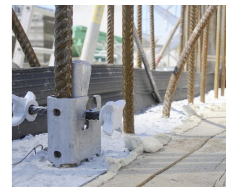
«RISA V-20»: Der weltweit erste Anschlaghalter, der nur aus zwei Teilen besteht und sich automatisch den Anschlusseisen-Durchmessern von bis zu 20 Millimetern anpasst.
