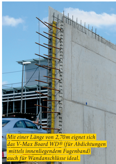
Mit dem BEGO®-Deckenrand-Abschalungssystem wird die Wand und der Deckenrand gleichzeitig erstellt. Nach dem Ausschalen der Wand ist die Decken-Stirnschalung fertiggestellt.
