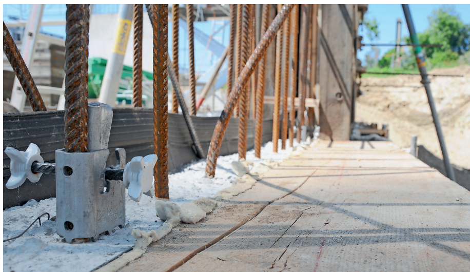
Die Anschlaghalterung RISA V-20, die sich automatisch an Anschlusseisen bis 20 mm Ø anpasst eignet sich in der Dimension 10 cm auch beim Einsatz von Fugenbändern.
