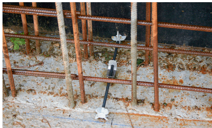
Der RISA 2000 ist die schnellste Anschlag- bzw. Distanzhalterung und kann ohne Werkzeuge ausgerichtet und fixiert werden.
