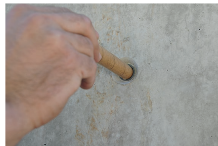
Die BSS Akustik-Schallschutzstopfen werden in die Bindestellen gesteckt und beidseitig mit den üblichen Verschlusszapfen verschlossen.
