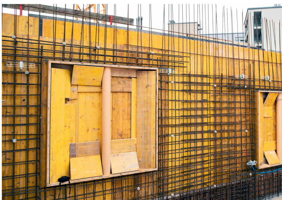
Bei Innenschalungen, Pfeilerschalungen oder Metallschalungen werden die ASK Konsolenanker mittels Montageplatte mit Eisenbindern an die Bewehrung gebunden.
