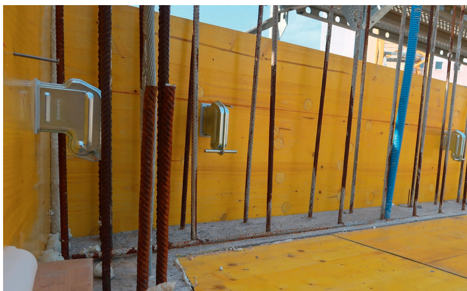
Mit dem neuen Montagekonus und dem ASK Konsolenanker spart man Montagezeit und Kosten, da die Aussparungen nicht mehr mit zusätzlichen Nägeln gesichert werden müssen.
