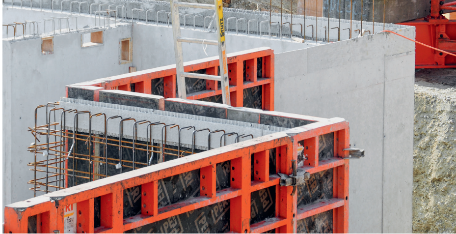
«BEGO»-Deckenrandabschalung: Gleichzeitig mit der Wand wird auch die Deckenrandabschalung fertiggestellt. Nach dem Ausschalen ist die Decken-Stirnschalung automatisch fix fertig erstellt.
