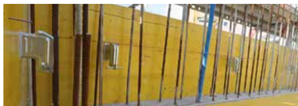
Sichere Montage der ASK Konsolenanker ohne zusätzliche Nägel.
