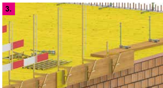
Montage des Schutzgeländers
