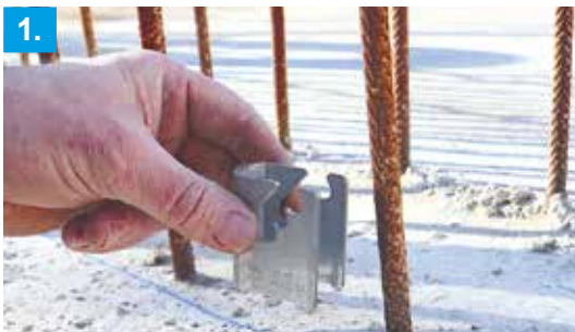
1. Manschette um das Anschlusseisen legen
