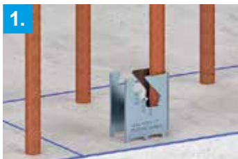
1. Manschette um das Anschlussseisen legen
