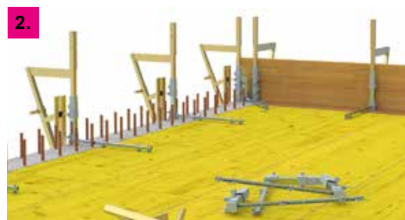
Erstellung der Deckenrandabschalung
